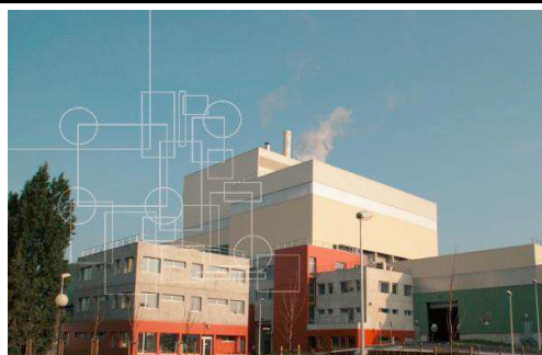
Centre de Valorisation Energétique de MONTEREAU FAULT YONNE
